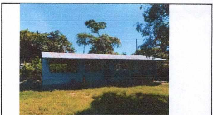
FOTO No. 4 SUSTITUCION DE TECHO DE AULAS
