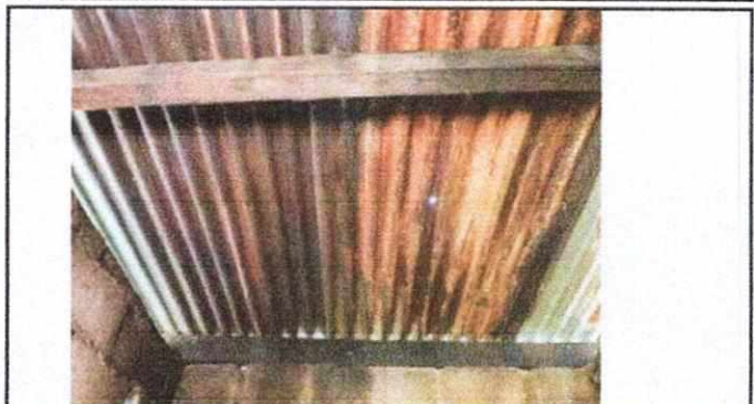
FOTO No.2 SUSTITUCION DE TECHO Y COSTANERA
