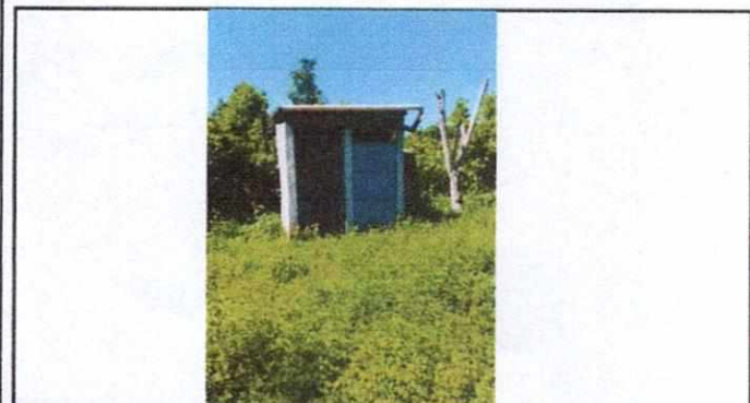
FOTO No. 3 INSTALACION DE UNA PUERTA METALICA Y UN TINACO
