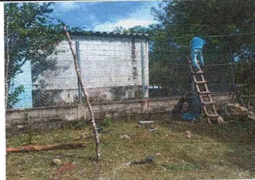
FOTO No.02 SUSTITUCION DE MALLA METALICA CON TUBO GALBANIZADO
