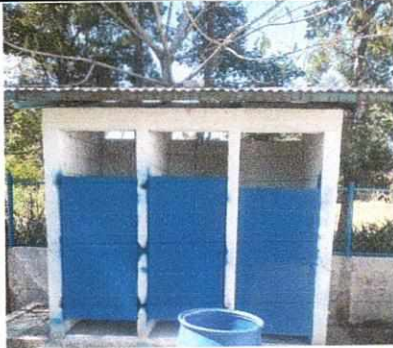
FOTO No.03 INSTALACION DE TECHO EN MODULOS DE BAÑOS
