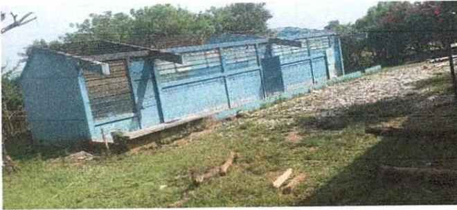
FOTO No. 01 SUSTITUCION DE TECHO DE DURALITA POR LAMINA TROQUELADA
