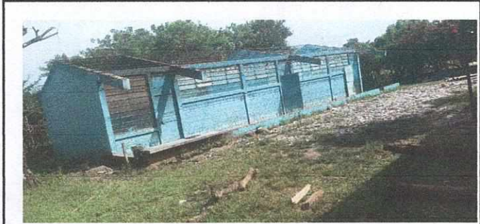
FOTO No. 01 SUSTITUCION DE TECHO DE DURALITA POR LAMINA TROQUELADA
