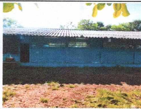
FOTO No. 02 Cambio de techo
