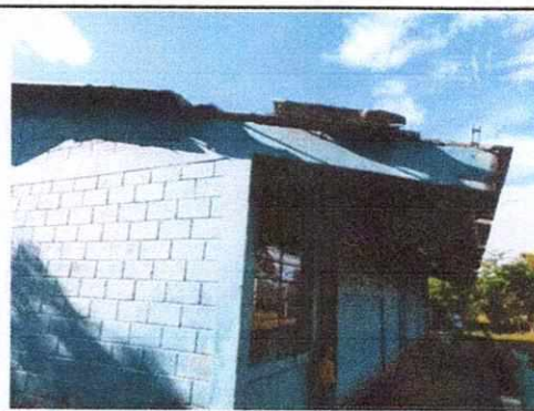
FOTO No. 04 sustitucion de techo
