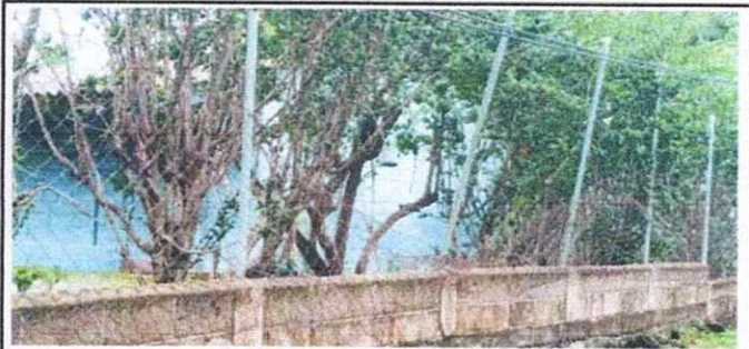
FOTO No. 03 Sustitucion de muro perimetral
