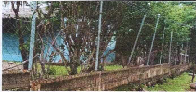
FOTO No. 01 Muro Perimetral
