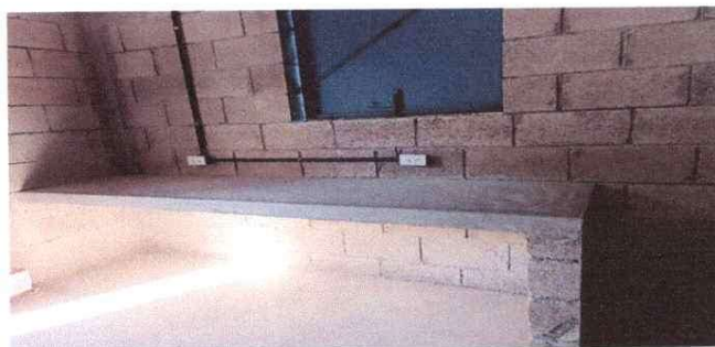
Foto 5: Mesa de concreto
