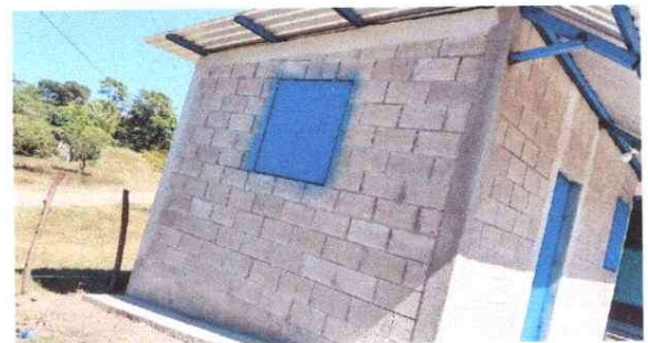
Foto 6: Puerta, ventas y techo
