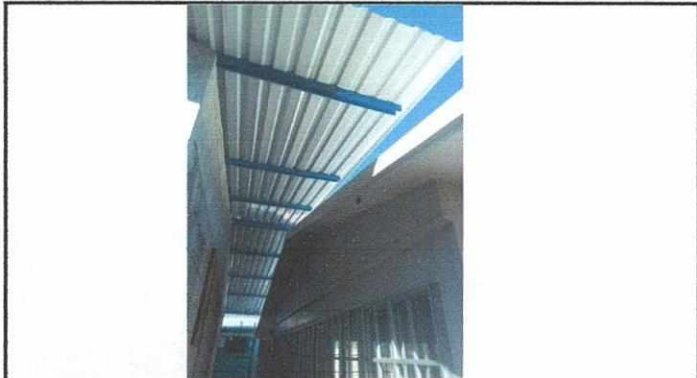
FOTO No.01 INSTALACION DE TECHO
