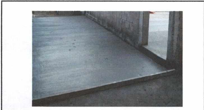
FOTO NO.03 FUNDICION DE LOSA EN AULA
