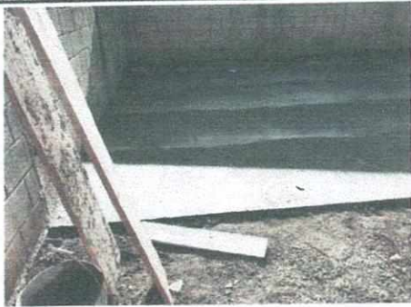
FOTO NO.03 FUNDICION DE LOSA EN AULA
