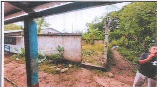
FOTO No. 02 Instalacion de puerta
