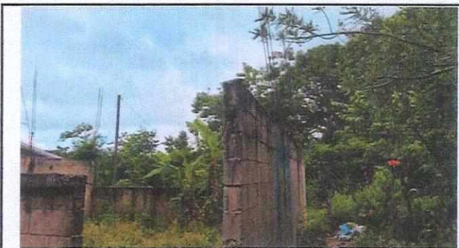
FOTO No. 04 Muro perimetral
