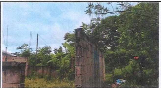
FOTO No.03 Instalacion de balcones metalicos
