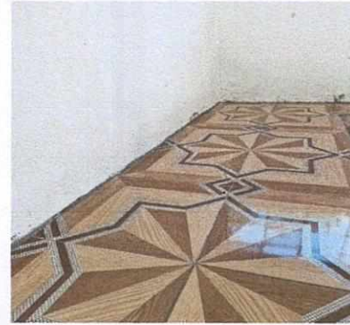
Foto 2: Sustitución de torta de cemento por piso cerámico.
