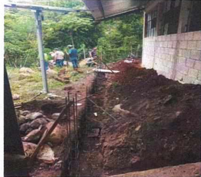
Foto 2: Implementación de muro perimetral.
