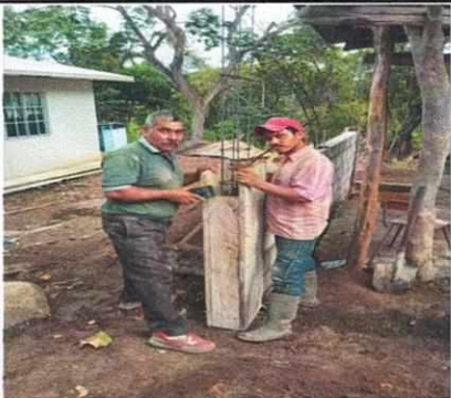
Foto 5: Sustitución paredes de lamina por block.
