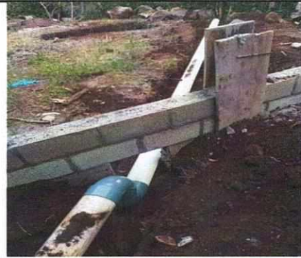
Foto 4: Implementación de tubería de drenaje.
