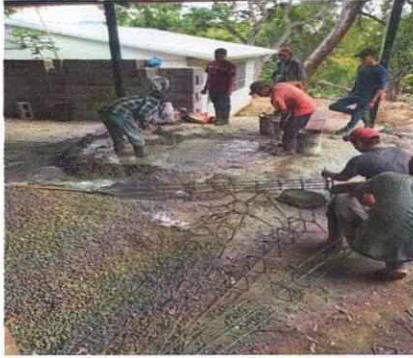
Foto 1: Sustitución paredes de lamina por block.
