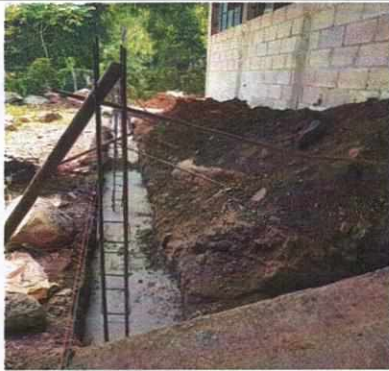
Foto 3: Implementación de muro perimetral.
