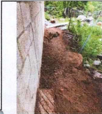
FOTO No. 01 Muro Perimetrak
