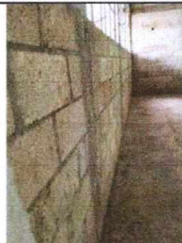
FOTO No. 06 Instalación de piso
