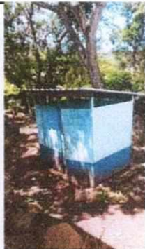
FOTO No.05 Sustitución de paredes baño, piso y puerta
