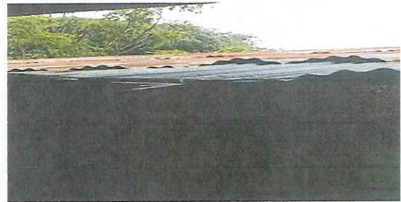
Sustitución de lámina por lámina troquelada
