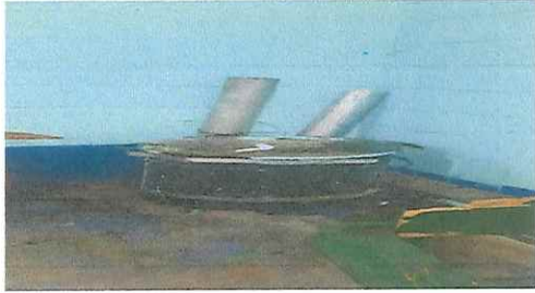
Construcción de polleton plancha metálica, chimenea, cerámico
