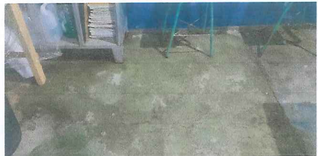
Sustitución de piso aula segundo A
