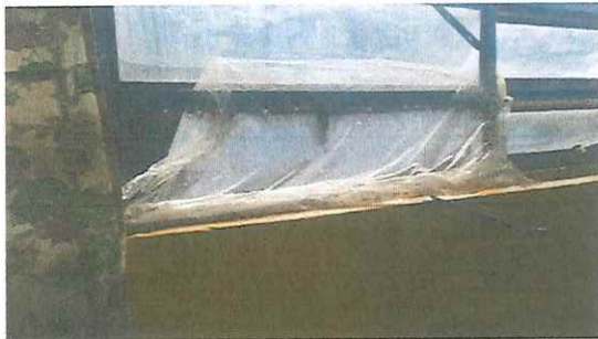
Sustitución de ventanas
