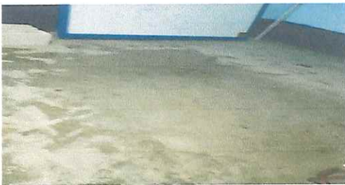
Sustitución de piso
