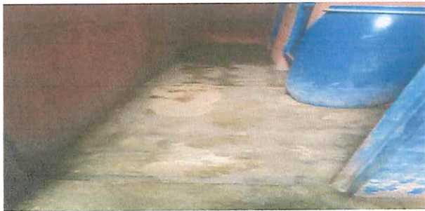
Sustitución piso baños
