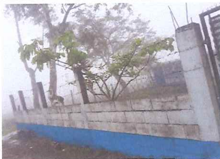
MODULO MURO PERIMETRAL
