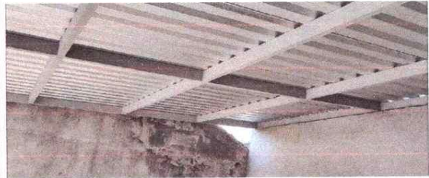
Sustitución de lámina por lámina troquelada y estructura en la cocina
