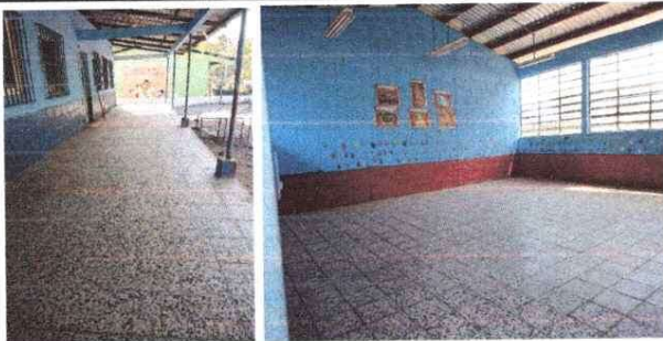
Sustitución de piso dañado dentro y fuera de las aulas
