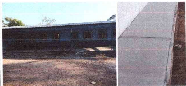
Reparación de banquetas de concreto
