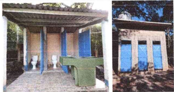
Remozamiento de servicios sanitarios
