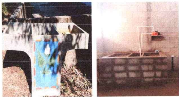
Sustitución de pilas en el área de cocina y servicios sanitarios
