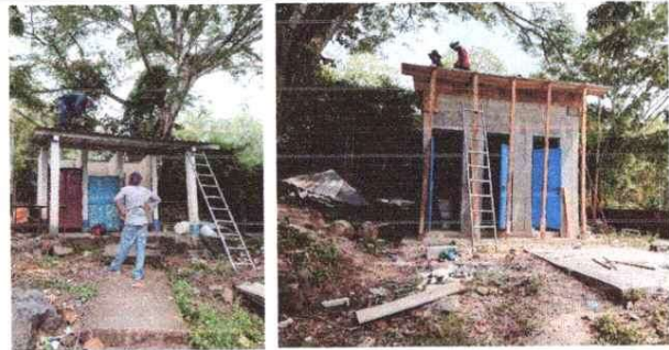
Remozamiento de servicios sanitarios
