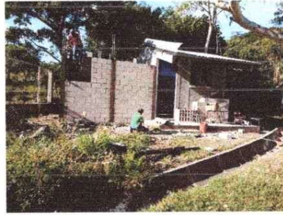
Sustitución de lámina por lámina troquelada y estructura en la cocina
