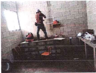
Sustitución de pilas en el área de cocina y servicios sanitarios
