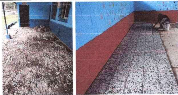
Sustitución de piso dañado dentro y fuera de las aulas
