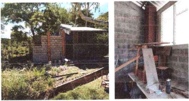
Remozamiento de cocina
