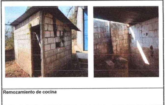
Sustitución de lámina por lámina troquelada y estructura en la cocina
