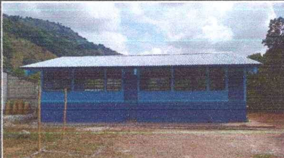
FOTO 4: FINALIZACIÓN DE PINTURA EN MUROS EXTERIORES E INTERIORES
