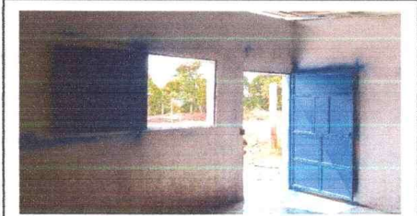
Foto 1: FINALIZACIÓN DE INSTALACIÓN DE PUERTA Y VENTANA EN LA COCINA
