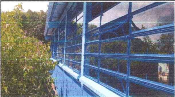
FOTO 4: FINALIZACIÓN LA INTALACIÓN DE LOS VIDRIOS
