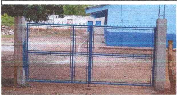
Foto 3: FINALIZACIÓN DE MANTENIMIENTO PORTÓN
