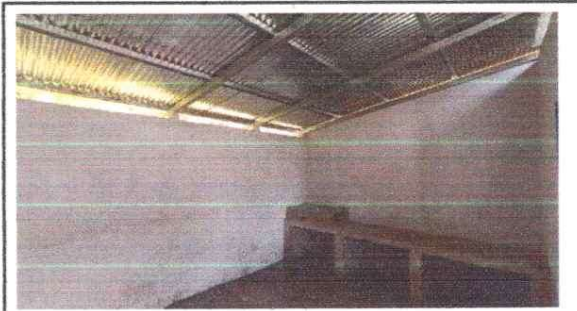
FOTO 6: FINALIZACIÓN DE COCINA SUSTITUCIÓN DE LAMINA, ESTRUCTURA, REPELLO, CERTIFICACIÓN Y TORTA DE CEMENTO
