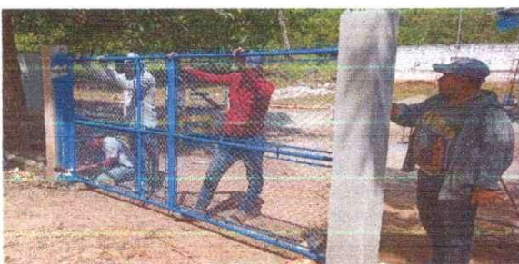
FOTO 5: INSTALACIÓN DE PORTÓN
