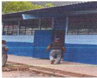
Foto 3: INSTALACIÓN DE CHASPAS EN PUERTA
