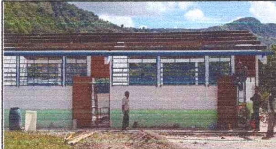
Foto 2: MANTENIMIENTO DE ESTRUCTURA
