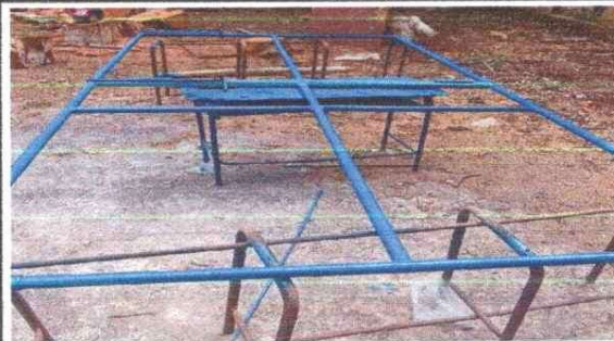
FOTO 4: MANTENIMIENTO DE PORTÓN
