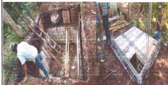
FOTO 6: CONSTRUCCIÓN DE UNA FOSA SÉPTICA
