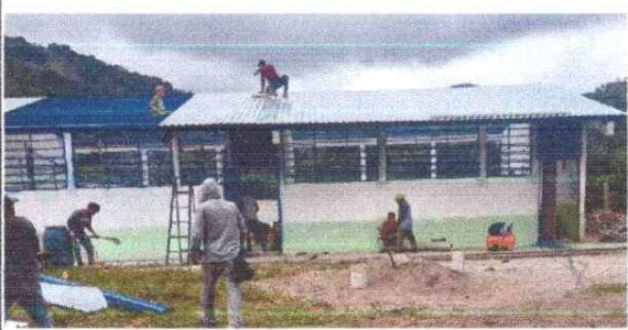
Foto 1: SUSTITUCIÓN DE LAMINA POR LAMINA TROQUELADA.
