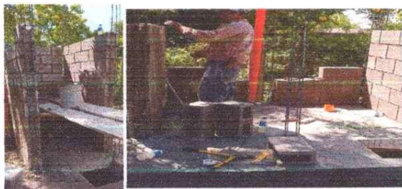
FOTO 5: RECONSTRUCCIÓN DE BAÑOS
