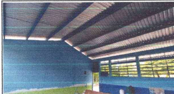
FOTO 6: PINTURA EXTERIORES E INTERIORES
