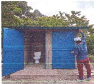
Foto 1: SUSTITUCIÓN DE LAMINA POR LAMINA TROQUELADA Y ESTRUCTURA
