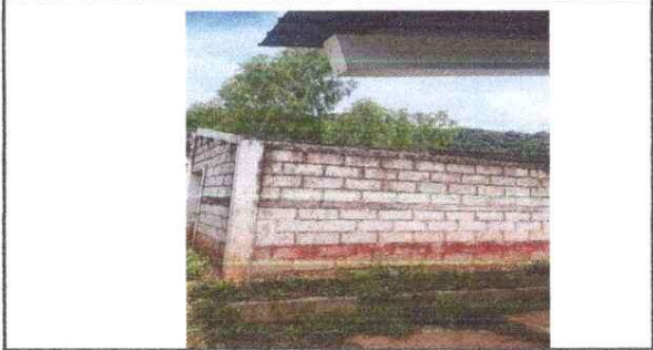
Sustitución de lamina por lamina troquelada, estructura, repello, cernido, y piso
