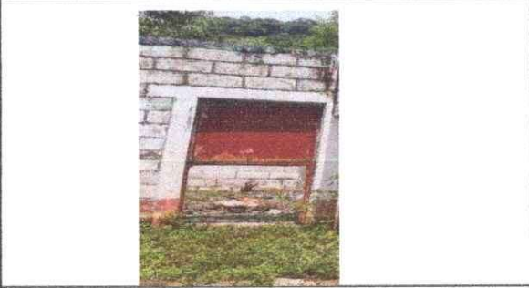
Sustitucion de puersta de cocina
