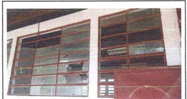
Mantenimiento y Sustitución de Vidrios
