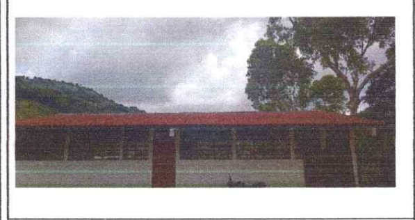
Sustitución de lamina por lamina troquelada
