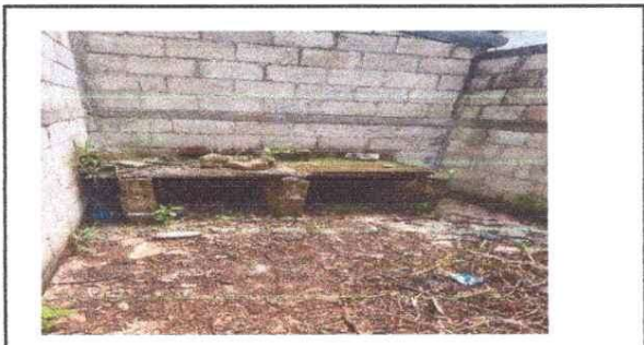
Sustitución de estufa rural por plancha
