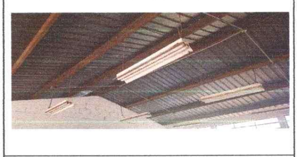
Mantenimiento de estructura en aulas
