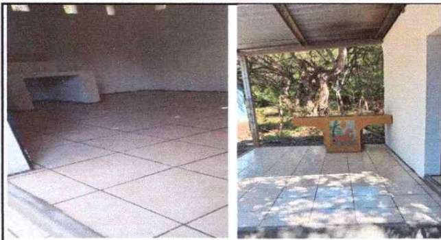
Sustitución de torta más instalación de sustitución de pila.
