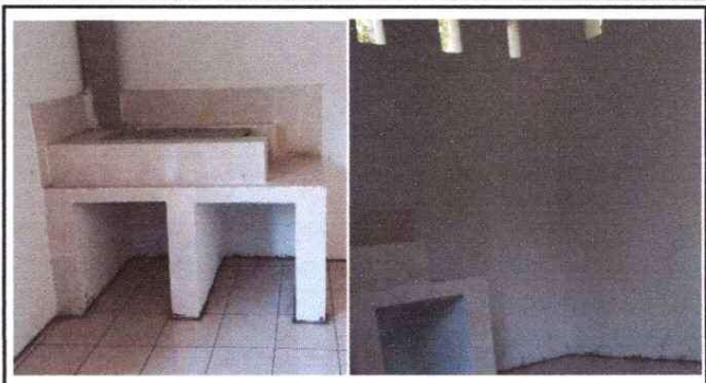
Remozamiento de cocina de leña. Repello y cernido en interior
