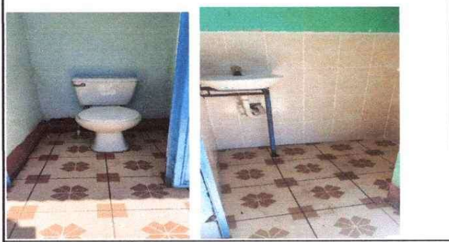
instalación de piso en sanitarios y azulejo en lavamanos.
