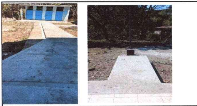
sustitución de banquetas, en aulas, sanitarios y cocina.
