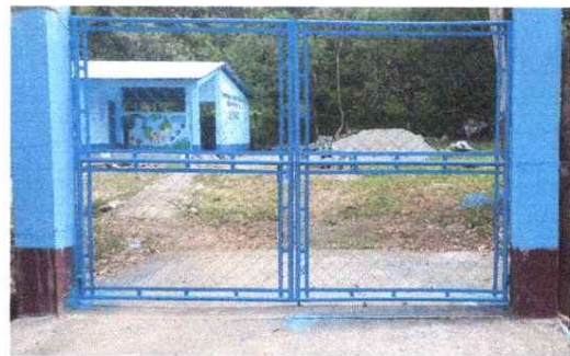
Reparación del portón principal
