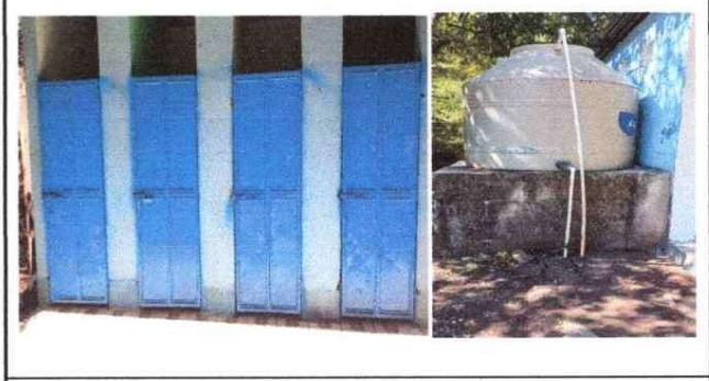
Pintura en puertas desanitarios, instalación de agua, y reparación de la red de agua potable.
