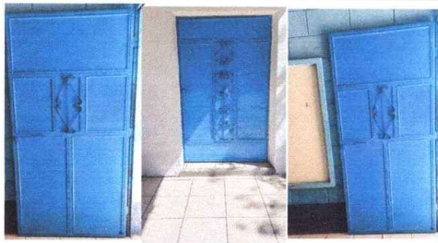
Pintura en puertas.
