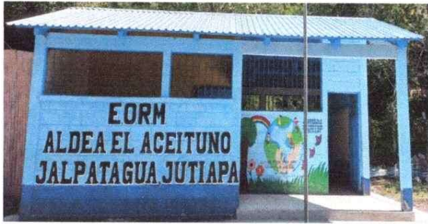
Sustitución de lámina por lámina troquelada calibre 26.
