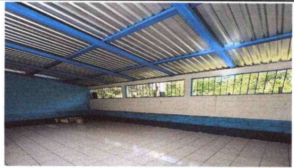
Pintura en costaneras existentes.
