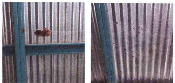
Sustitución de lámina por lámina troquelada calibre 26.
