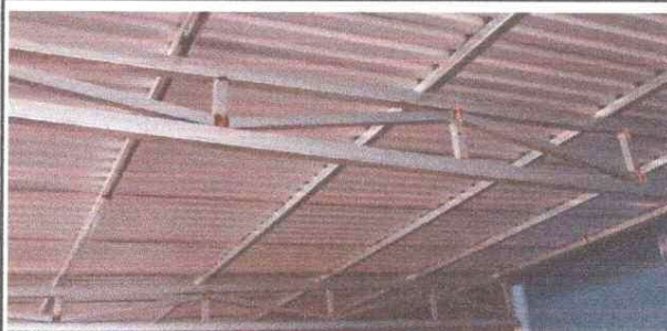
Sustitución de estructura de madera por estructura de metal
