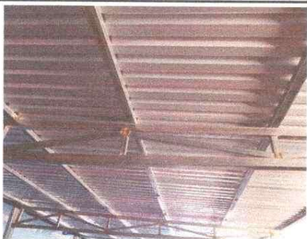
Sustitución de lámina, por lamina troquelada aluzinc calibre 26
