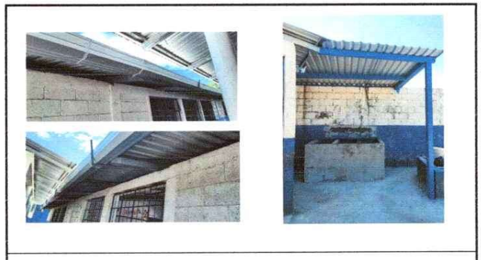
sustitución de canal
