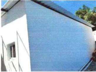
Construcción de dos hiladas de block sobre paredes existentes de cocina
