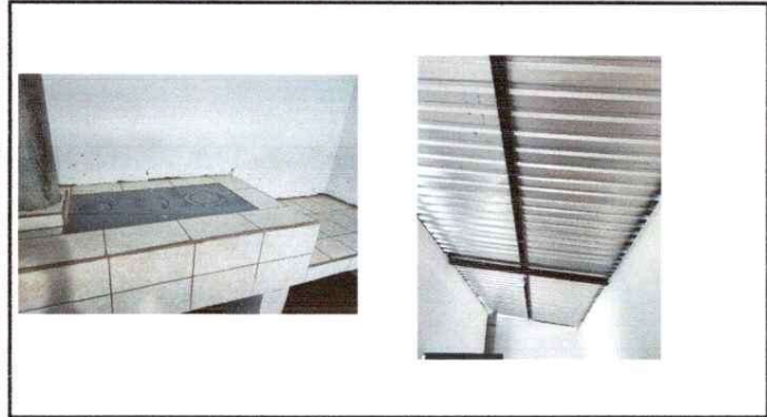
sustitución de lamina por lamna troquelada cal. 26
