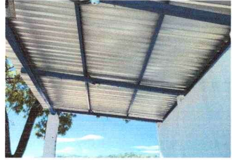
sustitución de lamina por lamina troquelada cal. 26
