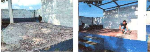
Sustitución de torta por piso
