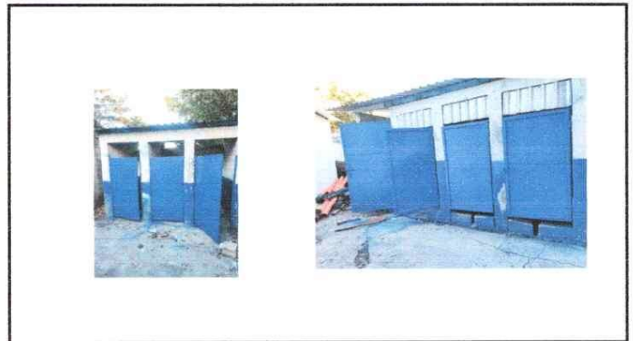
sustitución de puertas
