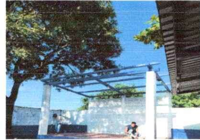
sustitución de lamina por lamina troquelada cal. 26
