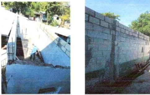
Construcción de dos hiladas de block sobre paredes existentes de cocina
