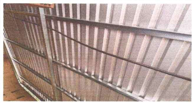
Sustitución de estructura de metal en la cocina.
