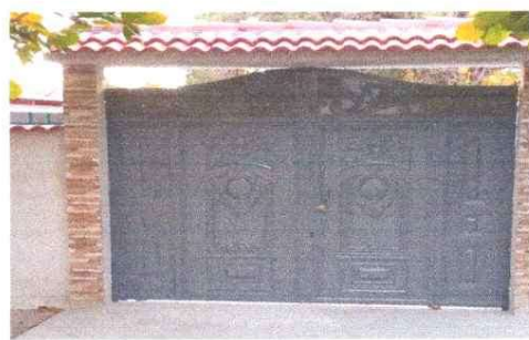
Sustitución de Portón
