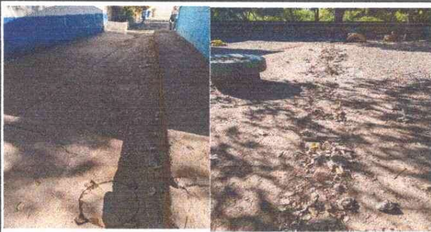
Sustitución de tubería de cemento por tubería PVC línea principal de aguas
