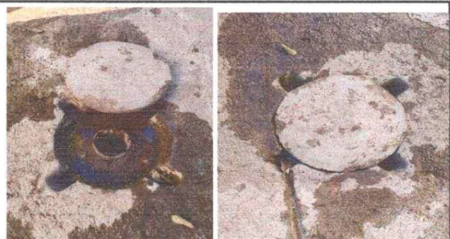
Sustitución de caja de registro y tapaderas
