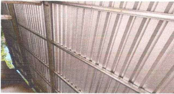
Sustitución de lámina por lámina troquelada
