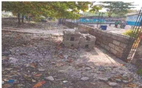
Se Sustitución de todo el Muro por que no tenia suficiente hierro en la fundición
