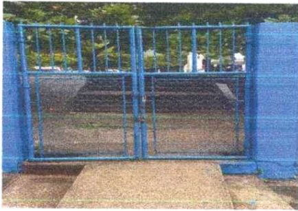
Sustitución de portón
