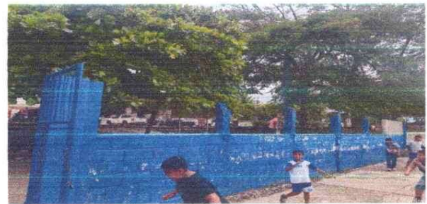
Pintura de muro perimetral
