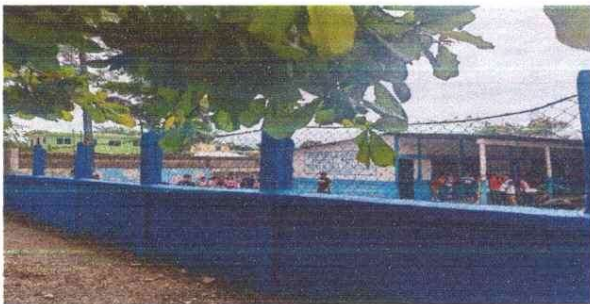
Sustitución de malla por blok
