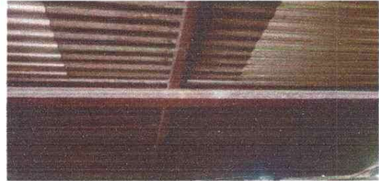
Sustitución de estructura de metal en la cocina.
