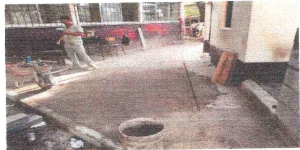
Reparación de piso de torta de concreto en frente de la cocina
