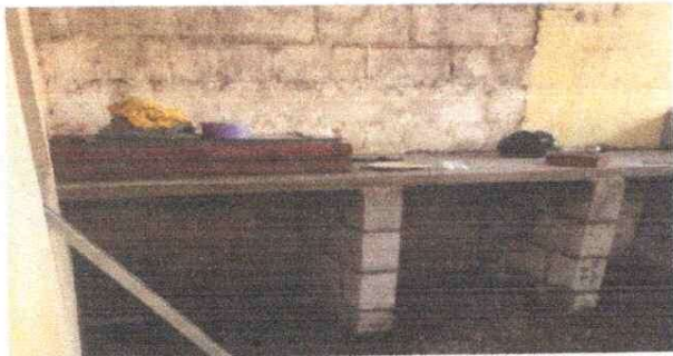
Sustitución de estufa rural por plancha con chimenea
