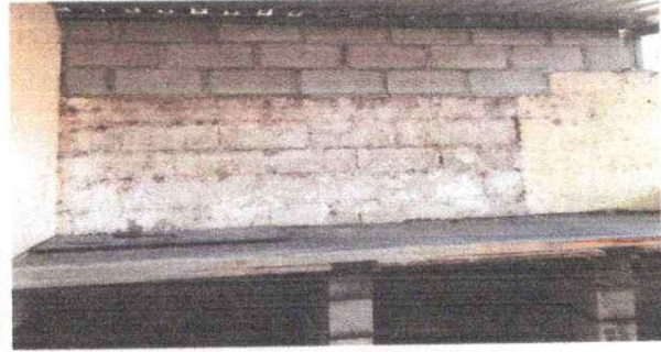
Remozamiento de pared
