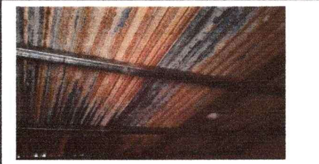
Sustitución de lamina por lamina troquila y estructura
