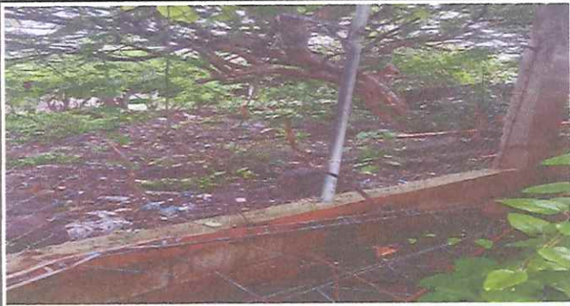
Foto 1: Muro de malla
