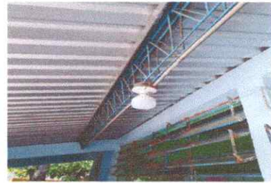
Reparacion sistema electrico
