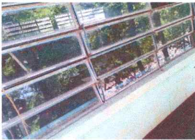
Sustitucion de vidrios
