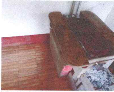
Sustitucion de torta de piso
