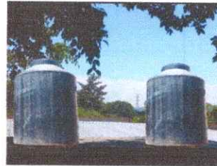
Sustitucion de agua potable
