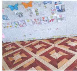
Sustitucion de torta por piso ceramico
