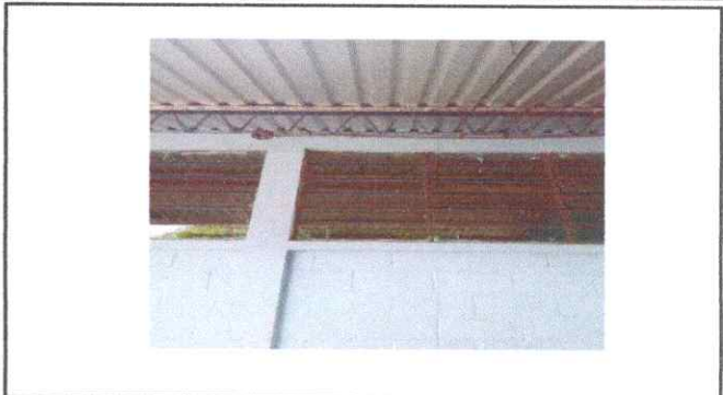
Reparacion sistema electrico
