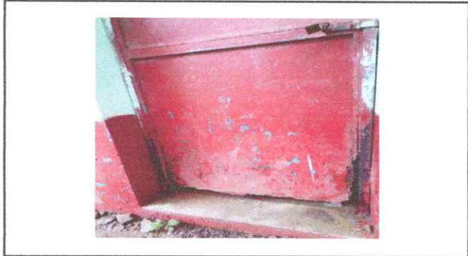
Reparacion de puerta
