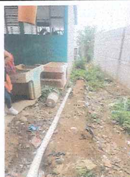
Foto 6: mejoramiento de pila y deposito de agua
