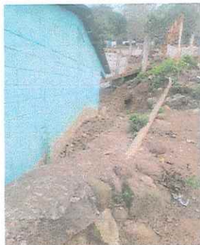
Foto1: meoramioento de muro perimetral parte 1
