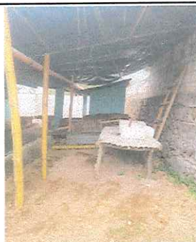
Foto 5: mejoramiento de techo de cocina
