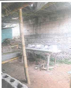
Foto 3: mejoramiento de piso de cocina
