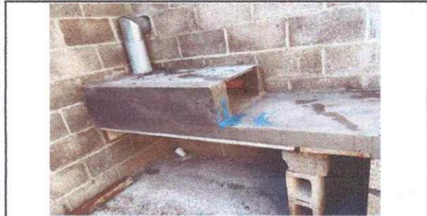
Foto1: Mejoramiento de estufa (completa) incluye plancha de metal
