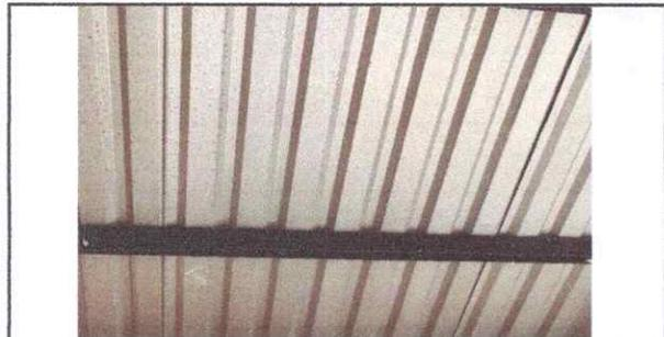
Foto 3: Mejoramiento e instalacion de lamina Auzinc calibre 26
