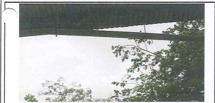
Foto 5: sustitucion de canal PVC y bajajadas de agua pluvial
