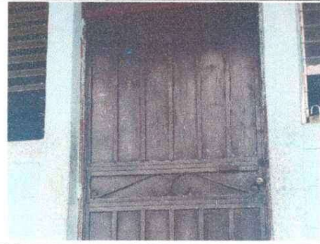
Reparacion de puertas
