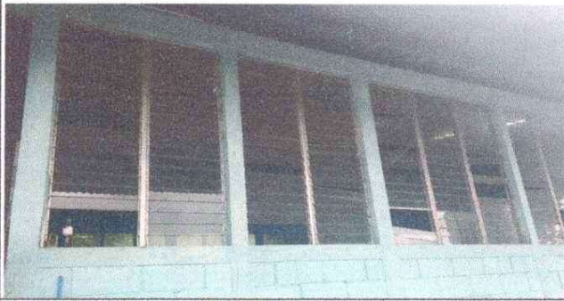
NOTA: ssutitución de ventanas
