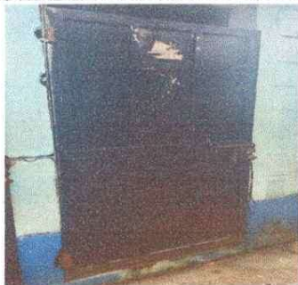
Reparación de puerta de baño
