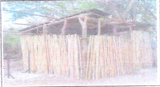
Levantado de paredes, repollo y cornido
