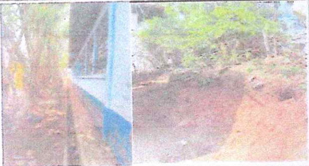
Muro perimetral de block, con malla galvanizada con tubo HG soleras y columnas.
