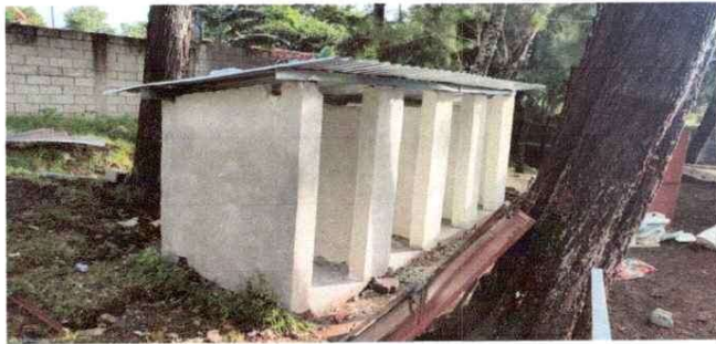
NOTA: repello de baños
