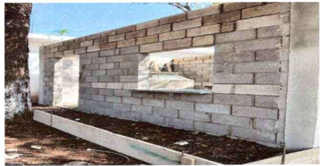
NOTA: Acera, ventana y puerta
