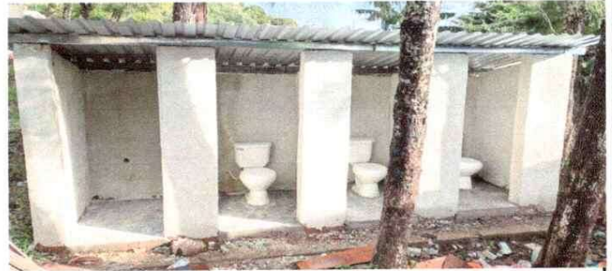
NOTA: Instalacion de baños y lamina
