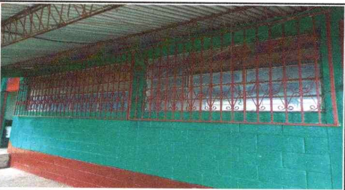
Foto 3 Mantenimiento de balcones de metal
