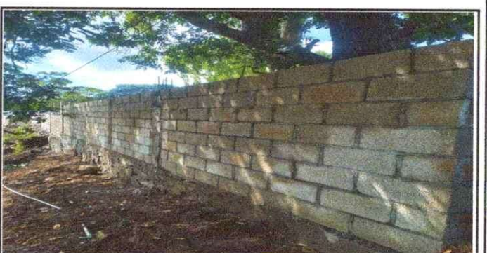
Foto 6 Reparacion de muro perimetral
