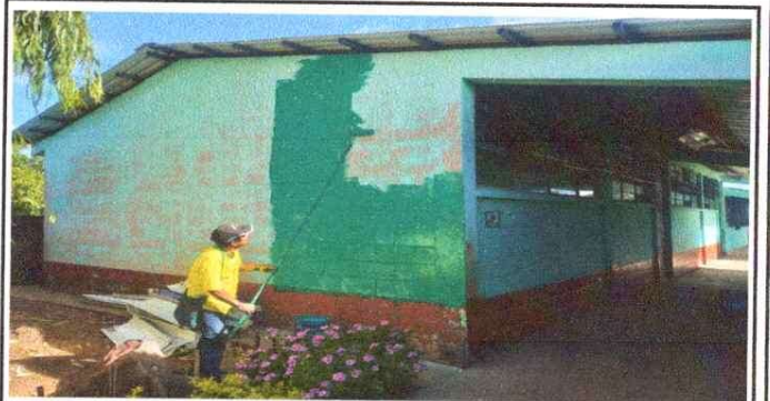
Foto 4 Pintura en muros exteriores e interiores
