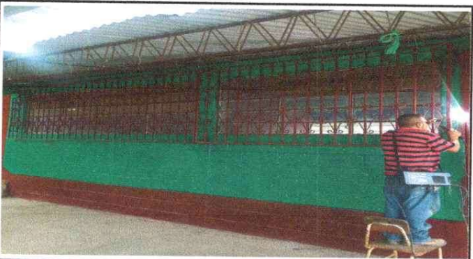
Foto 3 Mantenimiento de balcones de metal
