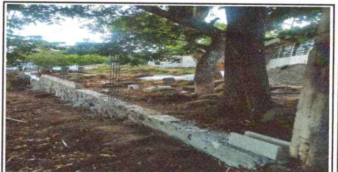
Foto 6 Reparacion de muro perimetral
