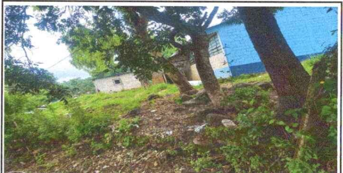
FOTO 6 Reparación de muro perimetral
