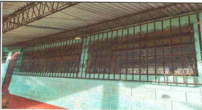
FOTO 3 mantenimiento de balcones de metal
