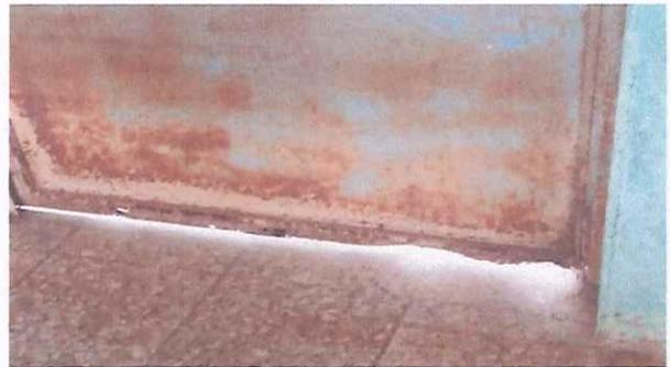
Foto 4: Puestas de las diferentes aulas oxidadas, picadas y quebradas de las visagras y provoca inseguridad a las mismas.
