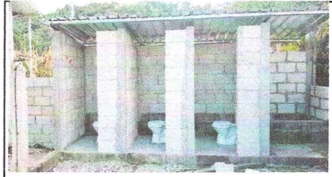
Instalación de baños y techado.
