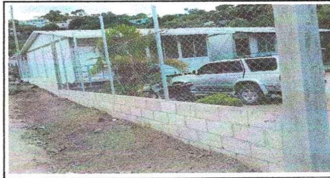
NOTA: Muro perimetral con malla Frontal.
