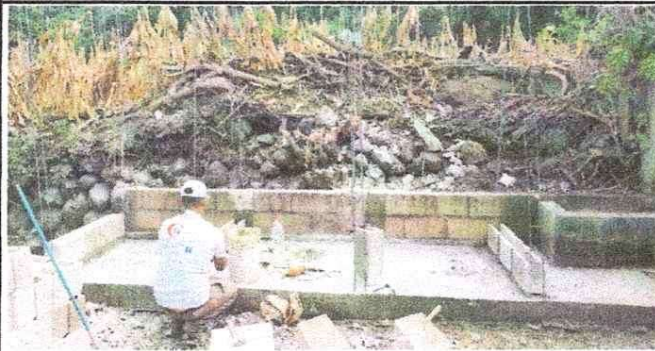
Llevando las paredes de baños.
