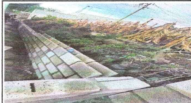
Levantado de muro perimetral.
