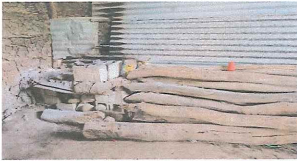
MEJORAMIENTO DE PISO DE COCINA
