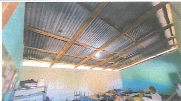
MEJORAMIENTO DE TECHO DE AULAS
