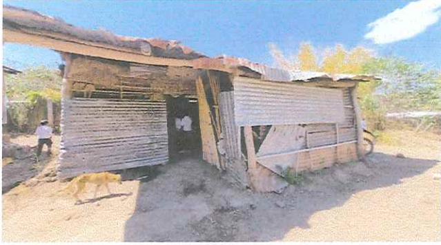
MEJORAMIENTO DE TECHO DE COCINA
