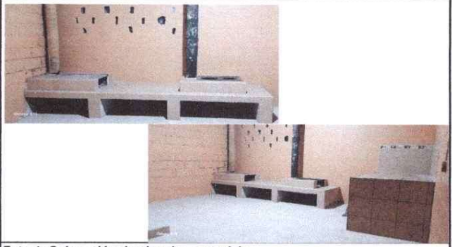
Foto 4: Colocación de planchas y azulejo.
