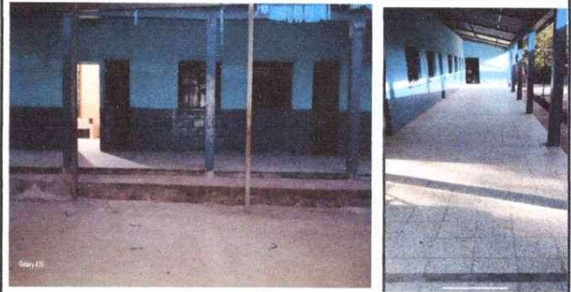
Foto 2: Piso de aulas y corredor
