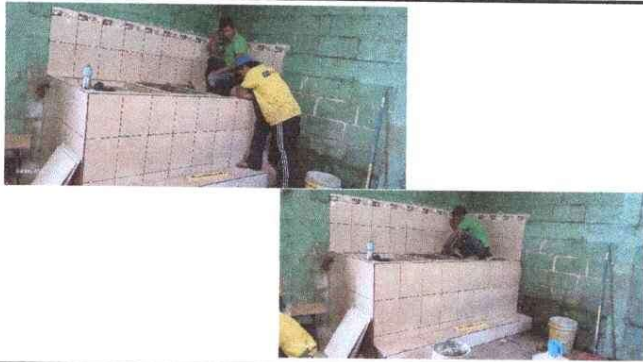
Foto 3: Reparación de pila y colocación de azulejo.
