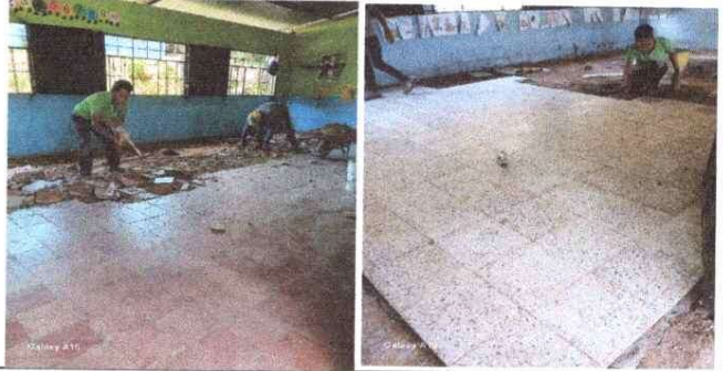
Foto 2: Piso de aulas y corredor
