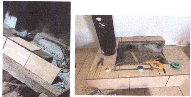
Foto 4: Colocación de planchas y azulejo.
