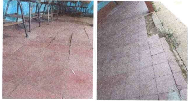
Foto 2: Piso de aulas y corredor
