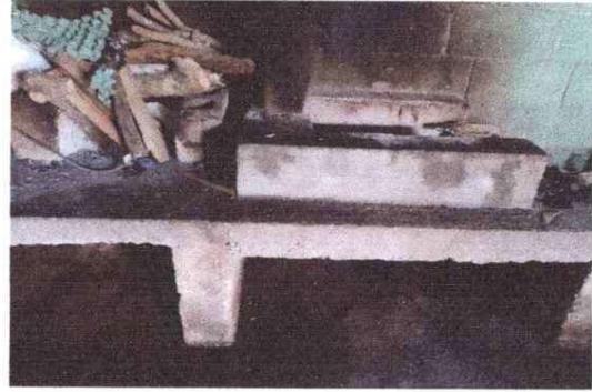
Foto 4: Colocación de planchas y azulejo.
