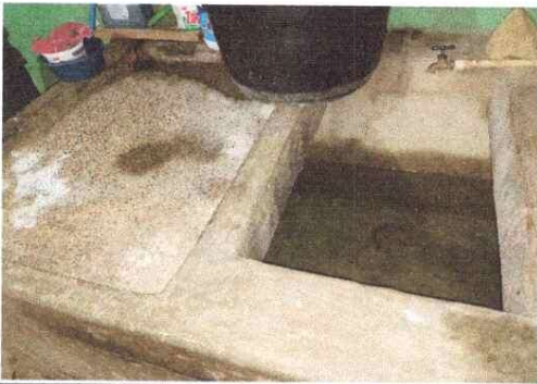
Foto 3: Reparación de pila y colocación de azulejo.
