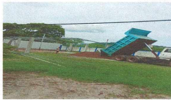
Foto 6: Construccion de una galera para actividades
