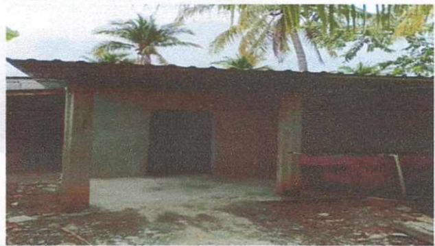
Foto.3 Reparacion de piso de concreto
