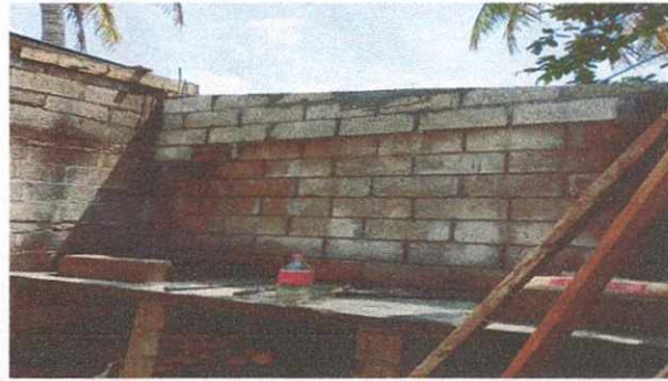
Foto.2 Repello cernido y chimenea a cocina
