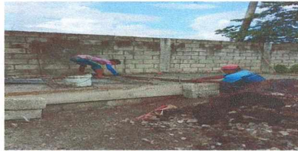
Foto.4 Reparacion de sanitarios y puertas
