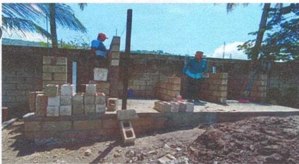
Foto. 5 Instalacion de tasas de china a sanitarios
