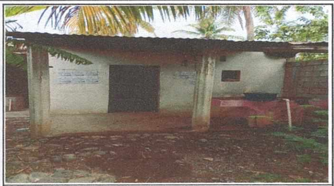
Foto.1 Cambio de techo y estructura metalica a cocina
