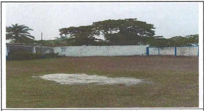
Foto 6: Construccion de una galera para actividades
