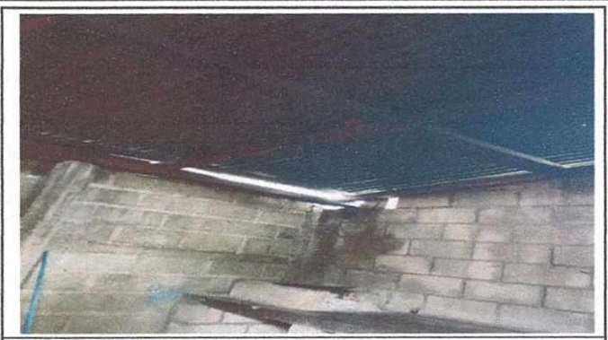
Foto.2 Repello cernido y chimenea a cocina
