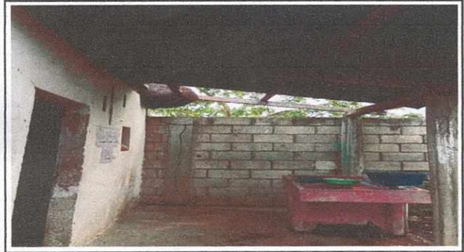
Foto.3 Reparacion de piso de concreto
