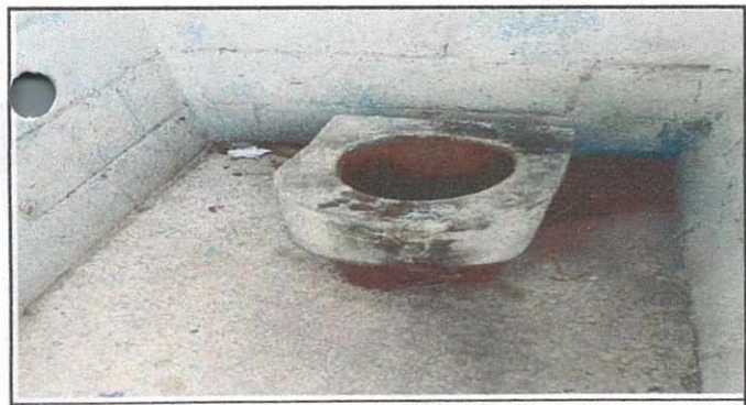
Foto. 5 Instalacion de tasas de china a sanitarios
