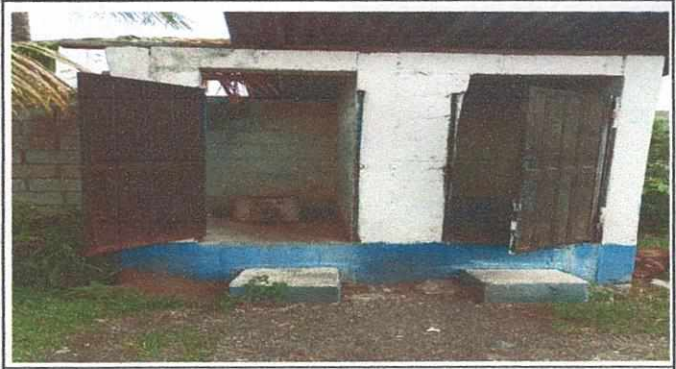
Foto.4 Reparacion de sanitarios y puertas
