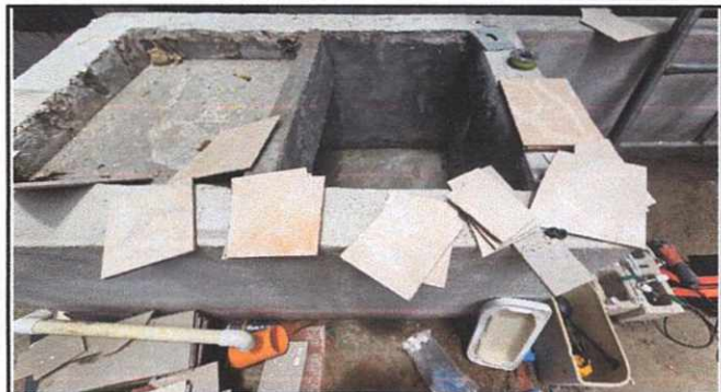
Sustitucion de pila de un lavadero en area de Sanitarios
