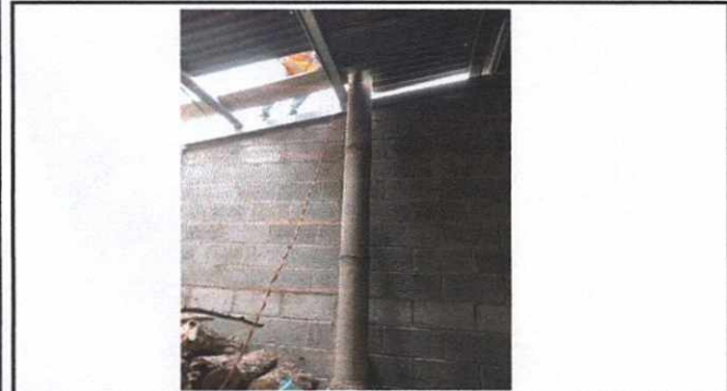
Sustitucion de Laminas de chimeneas en area de cocina
