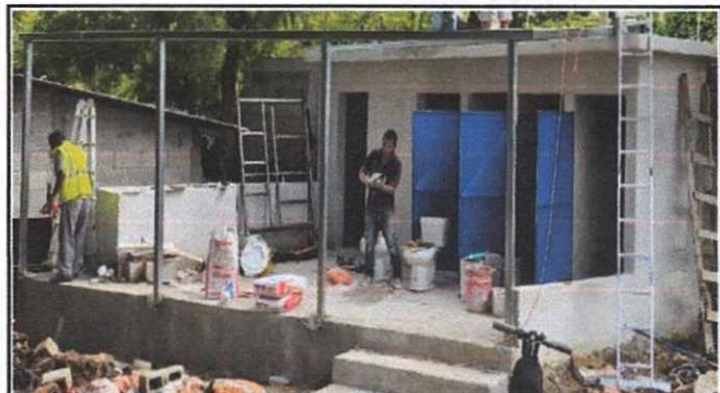
Sustitucion de lamina en corredor de sanitarios.
