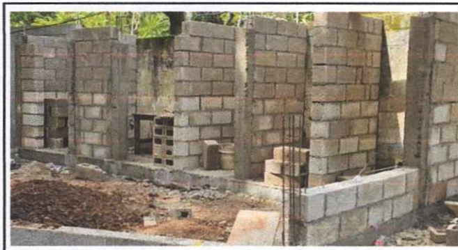
Sustitucion de paredes de Inodoros.
