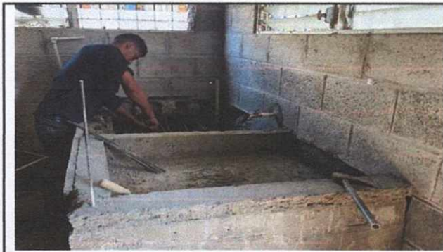
Sustitución de pila de dos lavaderos en area de cocina
