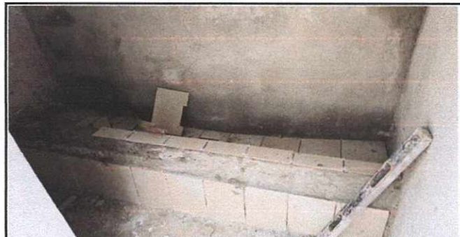
Instalacion de mingitorios con azulejo
